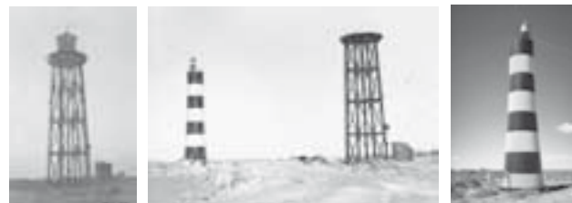
Imágenes de la antigua torre de hierro troncopiramidal sustituida luego por una torre cilíndrica.
