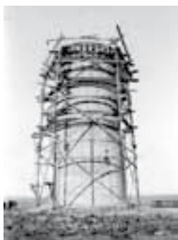
Fotografía del faro en construcción a mediados de 1947.
