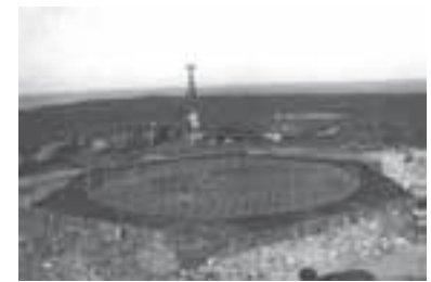
Inicios de la construcción del faro: preparación del terreno.
