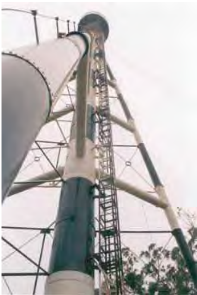
Detalle del ascensor del faro que permite el ascenso más cómodo de los visitantes.
