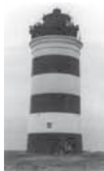
Imagen del faro ya terminado.
