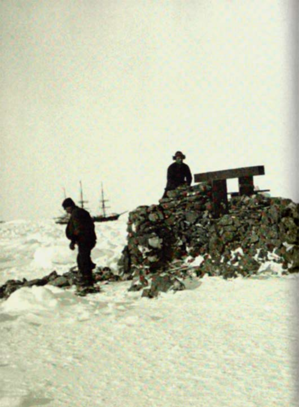
Levantando las paredes de piedra del refugio de Omond House
