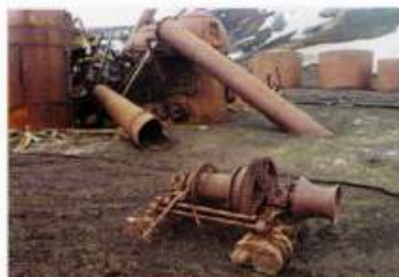
Isla Decepción. Calderas y tanques de la Cia Hektor, Caleta Balleneros. Deception Island: Bilers and tanks belonging to Cia. Hektor, Whalers Cove.
