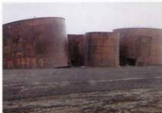
Isla Decepción. Tanques para el aceite de ballena (Caleta Balleneros). Deception Island: Tanks for whale oil storage. Whalers Cove.
